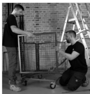
Přiložení stěny a srovnání pantů.
